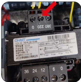
Esquema de Ligação 220V
