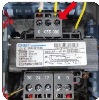
Esquema de Ligação 380V
