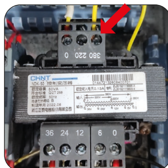
Esquema de Conexión 380V
