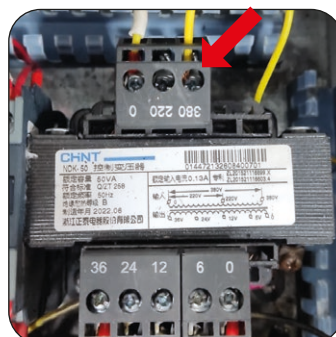
Esquema de Ligação 380V
